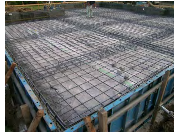
地中梁にて区画する耐圧版基礎構造
