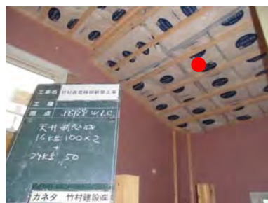
天井裏の断熱(厚み250ミリ)
