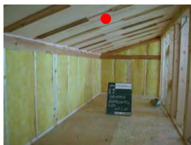
天井裏の断熱
